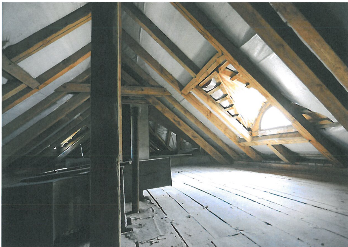
Ilustracja 8: Widok na konstrukcję dachu budynku zwierzątarni (B)
