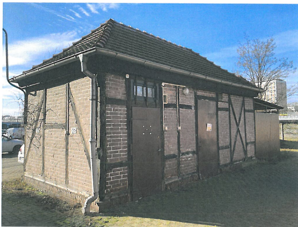
Ilustracja 5: Widok na budynek gospodarczy (C)
