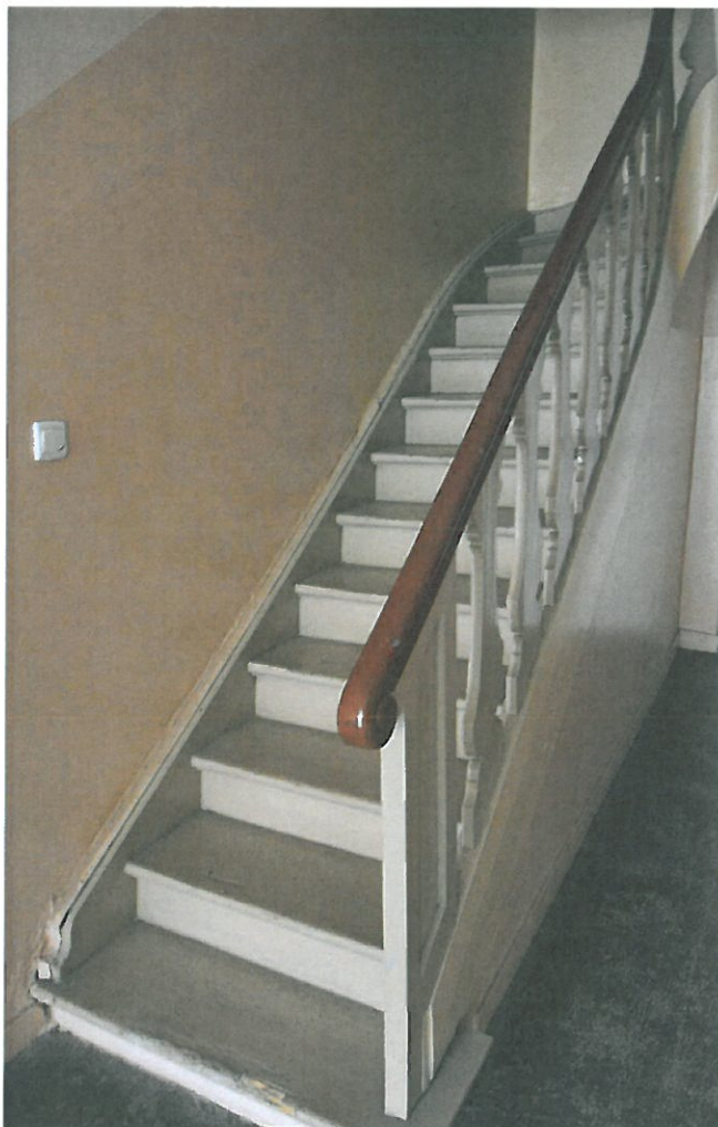
Ilustracja 10: Widok na schody na kondygnację techniczną
